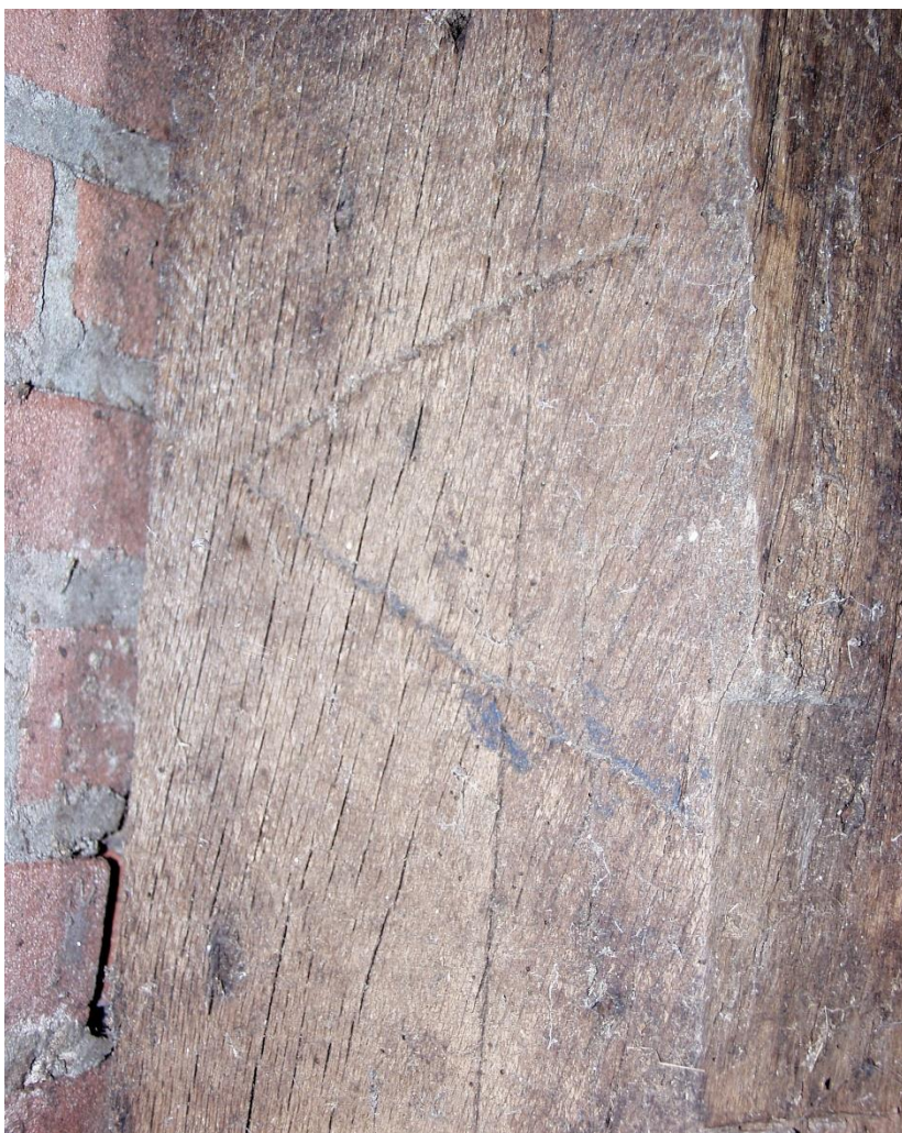
35. De telmerken in het achterste gedeelte zijn lang en veelal met een ritsmes aangebracht.
