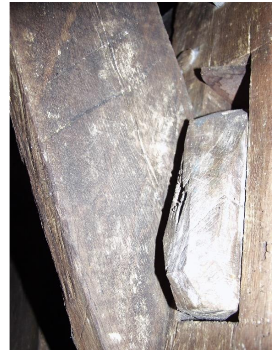
52. In het pengat van de westelijke staander zit nog een deel van de pen van de onderslagbalk.
