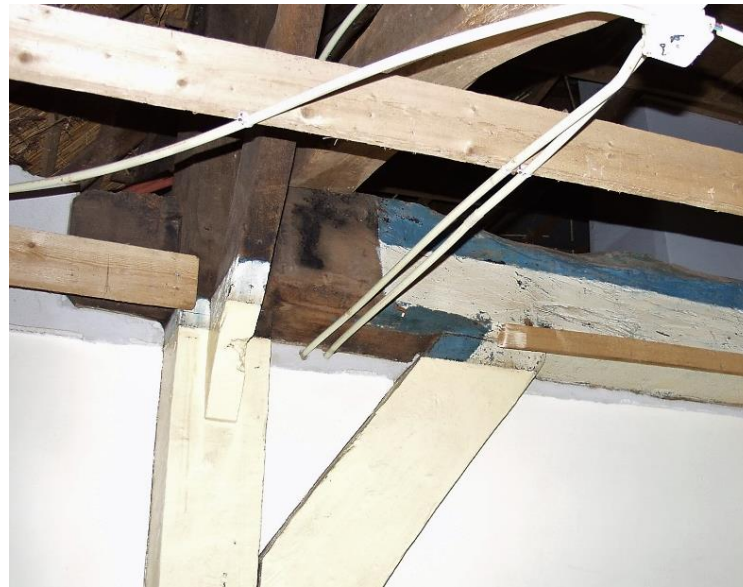
45. Overzicht voorste woonkamer met de ankerbalk van het tweede gebint en twee kleinere tussenbalken.
