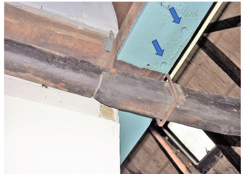
64 – 67. De balkenconstructie waarop de moderne schoorsteen rust bestaat blijkens de gaten voor toognagels (pijlen) uit hergebruikte eiken balken. Bijzonder zijn de inzetstukken aan beide zijden op de overgang van de schouwboezem naar de schoorsteen.
