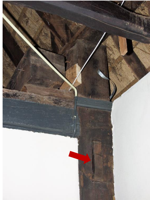
51. Pengat voor de onderslagbalk in de oostelijke staander van heet derde gebint.
