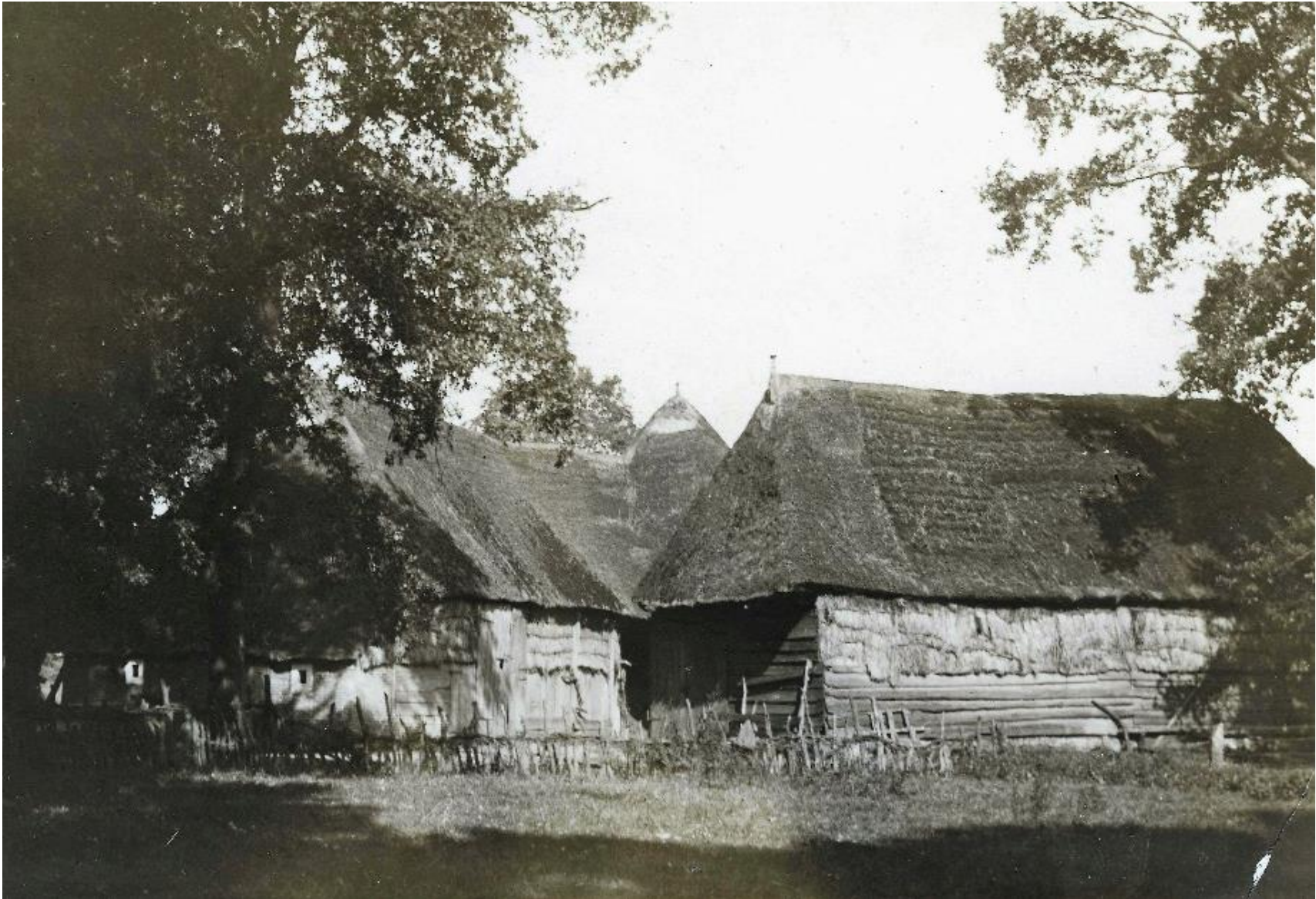
2. Vermoedelijk de oudste foto van het pand, gemaakt tussen 1887 en 1897. Helaas is de baander, die toen nog zijn oorspronkelijke vorm zal hebben gehad, niet zichtbaar. De schaapskooi heeft een strowand over de volle lengte van de zijgevel. (foto: Drents Museum).
