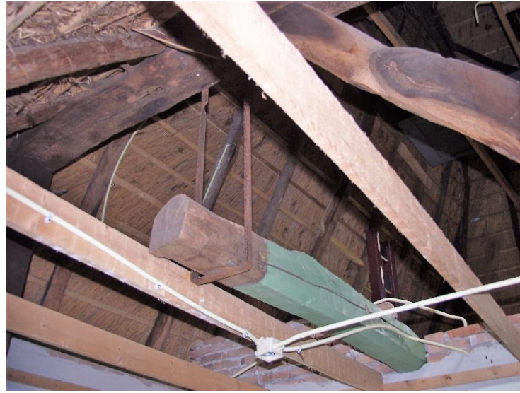
60. Ophanging aan de gebintplaat met smeedijzeren beugel
