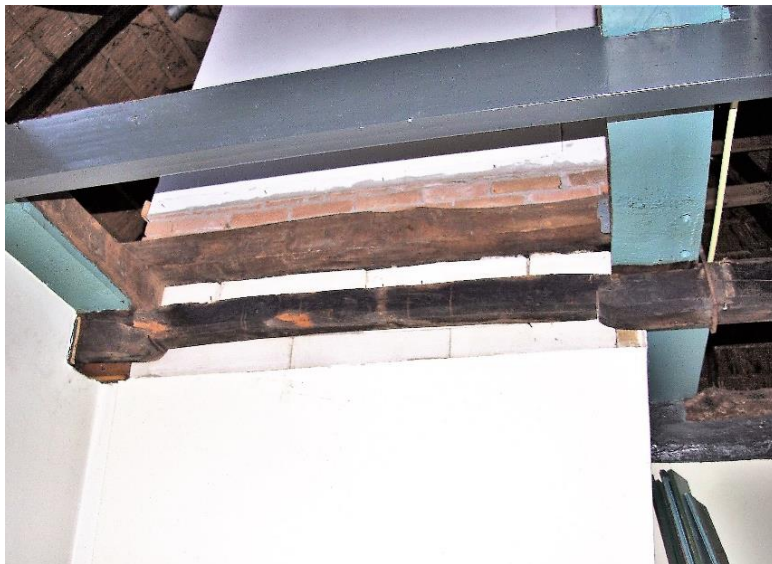
64 – 67. De balkenconstructie waarop de moderne schoorsteen rust bestaat blijkens de gaten voor toognagels (pijlen) uit hergebruikte eiken balken. Bijzonder zijn de inzetstukken aan beide zijden op de overgang van de schouwboezem naar de schoorsteen.
