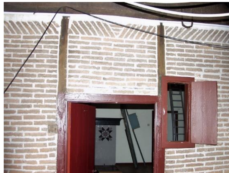
25. De toegang tot het woongedeelte in de brandmuur.
