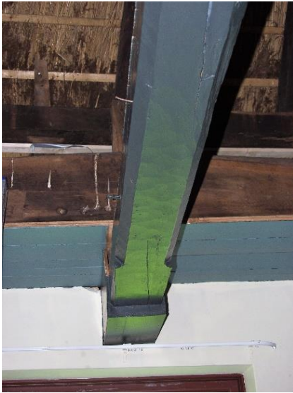
59. Een van de 'leugenbalken' met vellingkanten en kapelletjes
